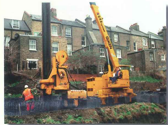
◀海外施工現場 (ロンドン)
