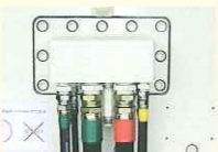
油圧ホース接続部
